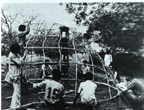
Gitterschale als Umkehrung der Kettenlinie
