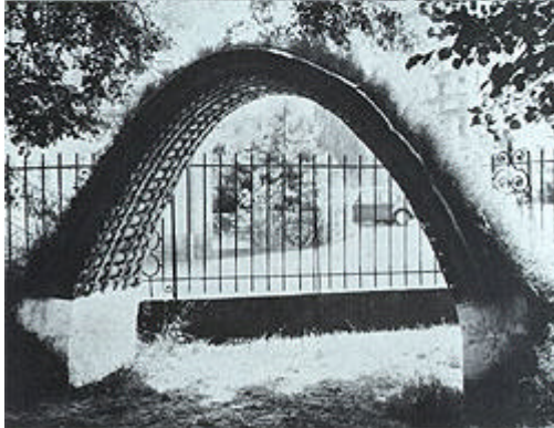
Hängende / Stehende Bogenkonstruktion
